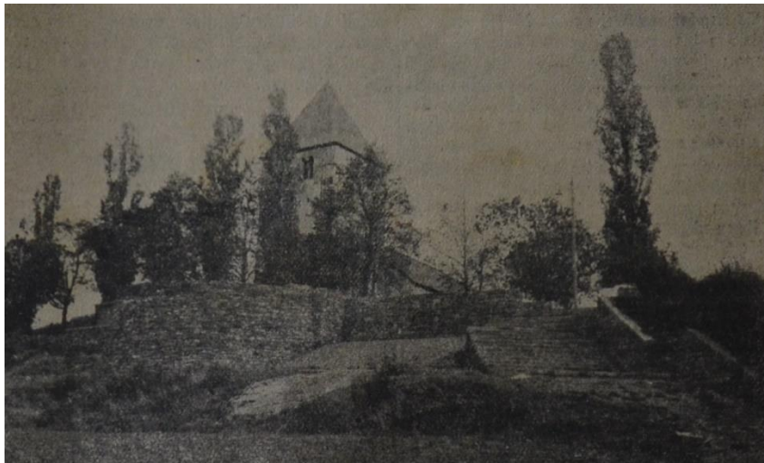
Abbildung 13: Alte Kirche mit dem im Bau befindlichen Ehrenmal. Quelle: Mechernicher Anzeiger 2.11.1932
