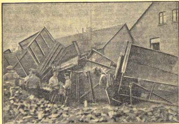
Auf der Braunkohlengrube vergisst bei Brühl, wo in der Nacht zum Freitag ein Kohlenzug wegen Verlagens der Bremsen einen Prellbock machte, ist ein müller Trümmerhaufen wie bei einem schweren Eisenbahnunglück zu sehen. Sieben von 16 Wagen sind umgeworfen und haben sich übereinander geschichtet. Der Heizer hatte, als die Bremsen nicht in Wirkung trat, Gegenstoß gegeben, aber es war bereits zu spät. Das Personal konnte im letzten Augenblick von dem mit Geschwindigkeit fahrenden Zuge abspringen, so daß Menschen nicht zu Schaden kamen.
