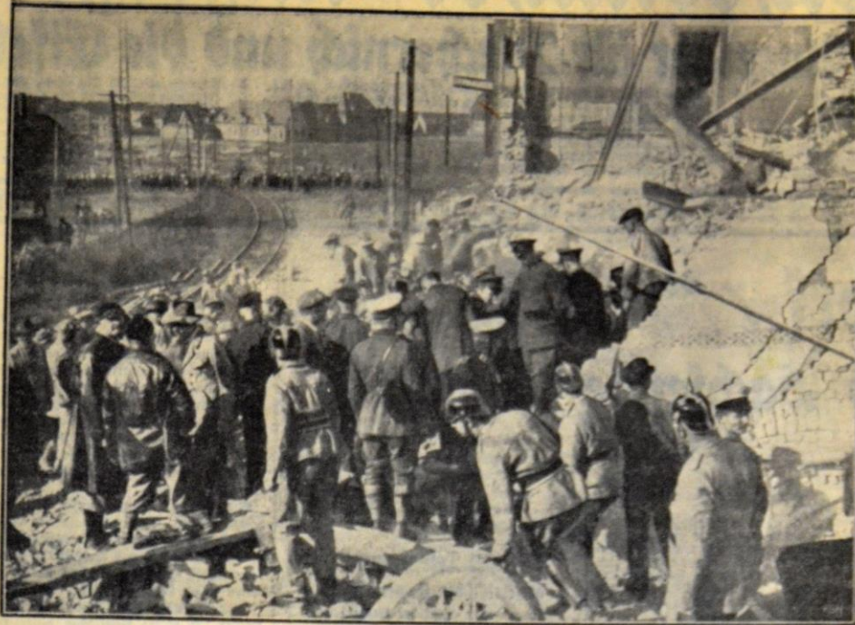
In dieser Stelle befand sich die Lampentube — in unmittelbarer Nähe des Schachteingangs
