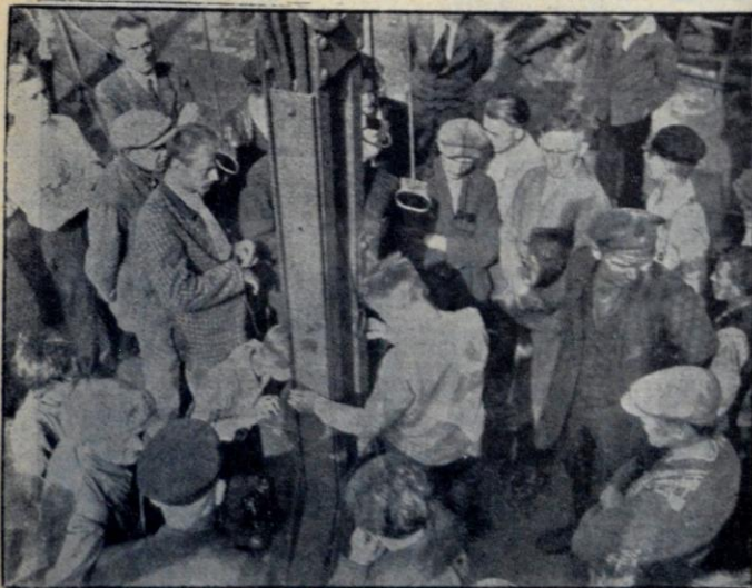
An der Schachtsohle
